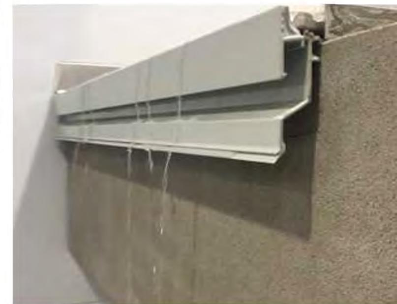
Ovaj profil je napravljen od varnished aluminijuma. Dizajniran je da zaštititi ivice postavljenog popločanja na terasama i balkonima, te da osigura pravilno ispuštanje vode. Profil ima odstojnik koji garantuje njegovo pravilno pozicioniranje kao i specijalnu vodopropusnu traku, u smislu drenaže vode, koja onemogućava silikonu da zatvori odvodne otvore na profilu.
